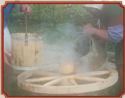
Nabenring wird auf die Nabe aufgeschraubt.
